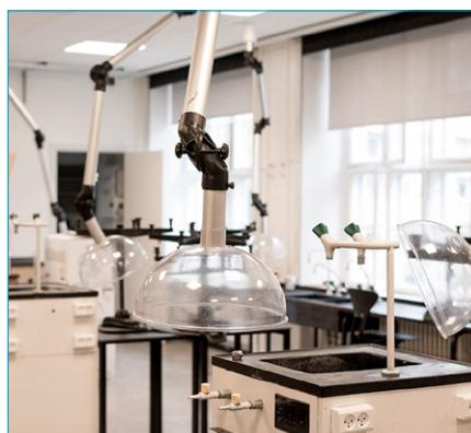
Perma Arm è il braccio ideale per essere usato in aule di laboratorio di scuole, con cappe in policarbonato installate sopra ogni banco.
